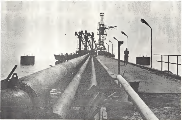
Dock nobo di Lago pa e planta di Disulfuración cu actualmente ta den "full swing" di construcción.
